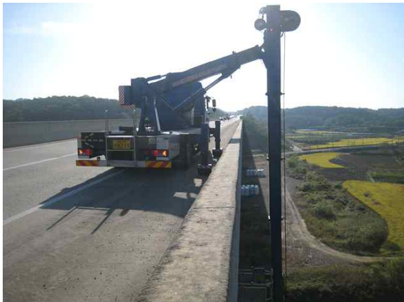
교량점검차를 이용한 근접조사
